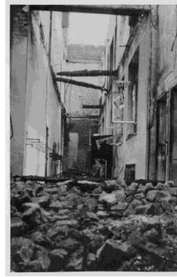
Blick einen Flur der Schule
